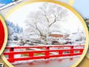
สะพานนากะบาชิ
